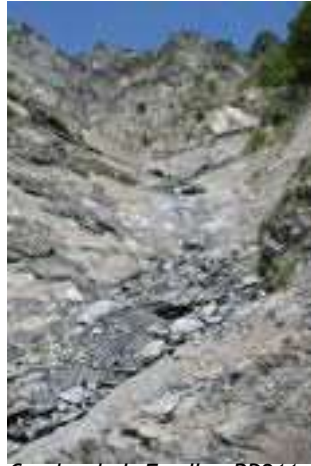
Combe de la Fayolle - RD211a Falaise et éboulis
