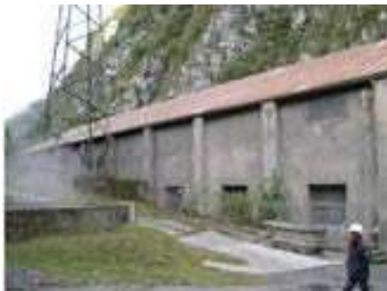
Centrale de Pierre-Eybessse. Sources : http://www.isere-patrimoine.fr
