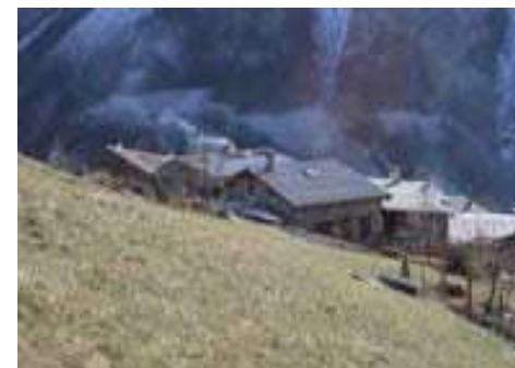
Ancrage des pignons Nord dans le versant
