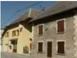
A gauche un bâtiment réhabilité et à droite un bâtiment non réhabilité. Le bâtiment réhabilité semble avoir des ouvertures modifiées dans leurs proportions, la marquise n'a pas lieu d'être, les volets ne sont pas peints, les décors non conservés (s'ils existaient) : angles et encadrement de fenêtres peints.
