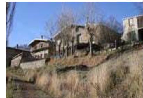
Pignons Sud ouverts sur la vallée de la Salse, extrémité Ouest du village
