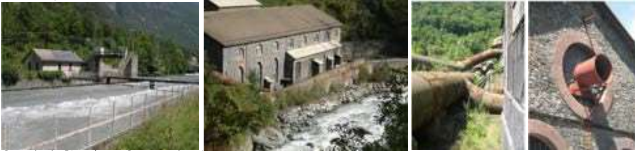
Centrale de Rioupéroux. Sources : http://www.isere-patrimoine.fr
