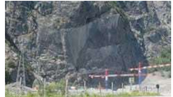
Sécurisation des versants dans le cadre des travaux EDF de la vallée de la Romanche
