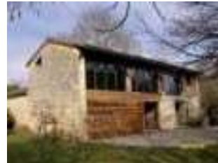
Exemple de transformation de grange en maison d'habitation rendant lisible la fonction première (baies vitrées à la place des ouvertures originelles, mise en valeur de la charpente, utilisation d'un vocabulaire de type grange pour les volets, etc.).
