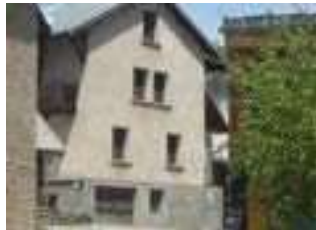
Ce bâtiment, fortement transformé, a perdu toutes ses qualités d'origine : enduit à la chaux, ouvertures d'origine, perception des usages d'origine.
