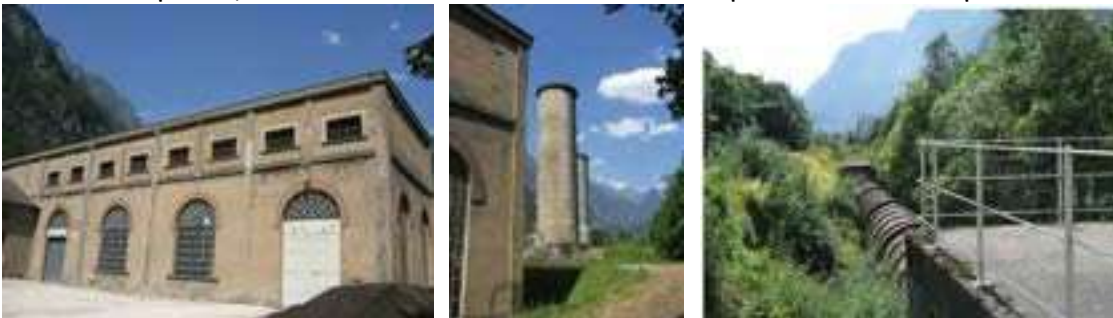
Centrale des Clavaux. Sources : http://www.isere-patrimoine.fr
