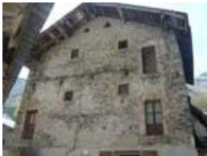
Une façade secondaire de la maison d'un notaire, mais composée (organisation des ouvertures entre elles) avec ses portes, ses petites ouvertures et en haut les trous d'aération du fenil. Chaque porte devait comporter un escalier.
